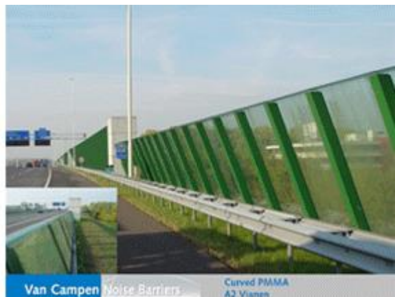
Фиг. 13 – Вертикална стена от готови прозрачни елементи - безцветни, Фиг. 14 – Наклонена стена от готови елементи, прозрачни – цветни
