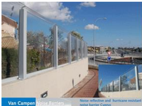
Фиг. 13 – Вертикална стена от готови прозрачни елементи - безцветни, Фиг. 14 – Наклонена стена от готови елементи, прозрачни – цветни
